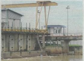
OPERASI Loji Rawatan Air Sungai Semenyih akan terjejas jika air Sungai Semenyih tercemar. — Gambar hiasan
